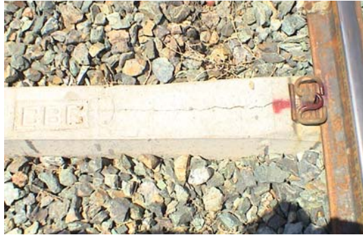
شکل الف-۱۹ - ترک طولی تراورس
