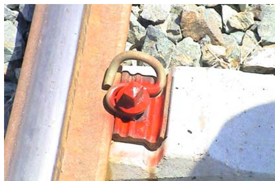
شکل الف-۱۷ - نمونه‌ای از یک فنر شکسته
