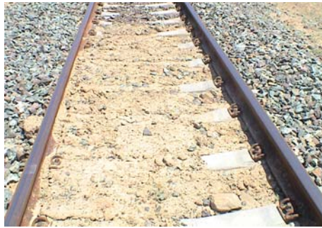
شکل الف-۲۰ - کثیفی بالاست
