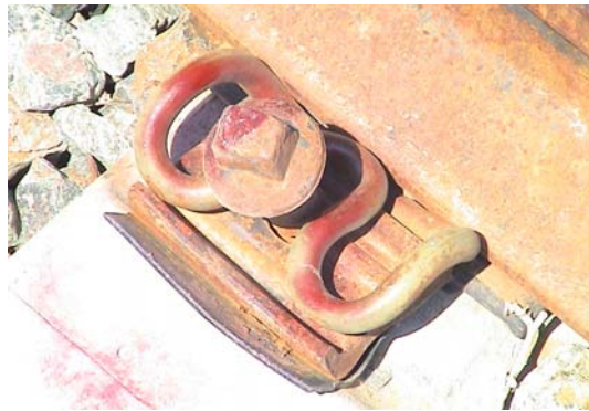
شکل الف-۱۸ - نمونه‌ای از یک فندر زنگ زده
